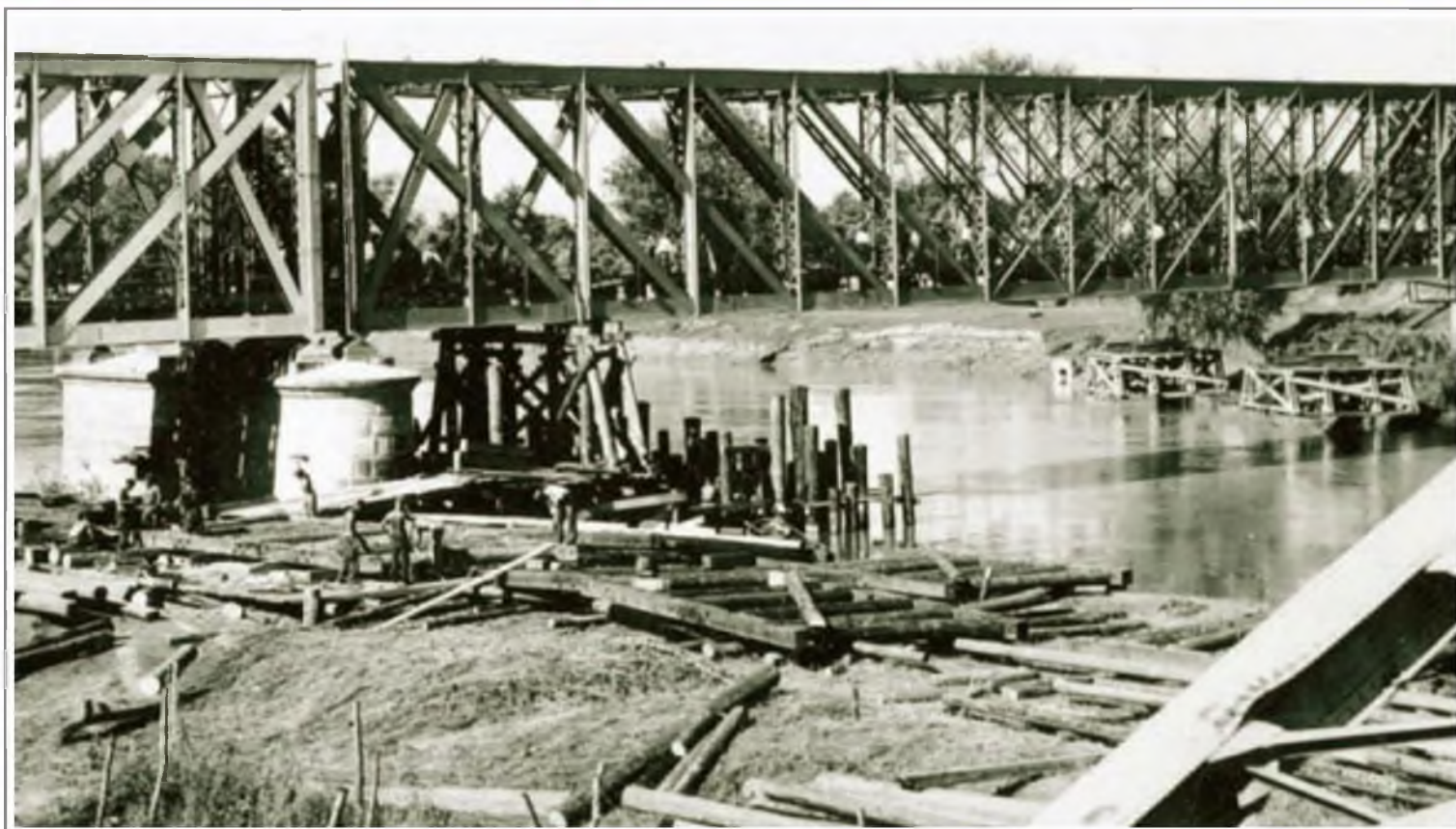
Construirea podului peste Prut
